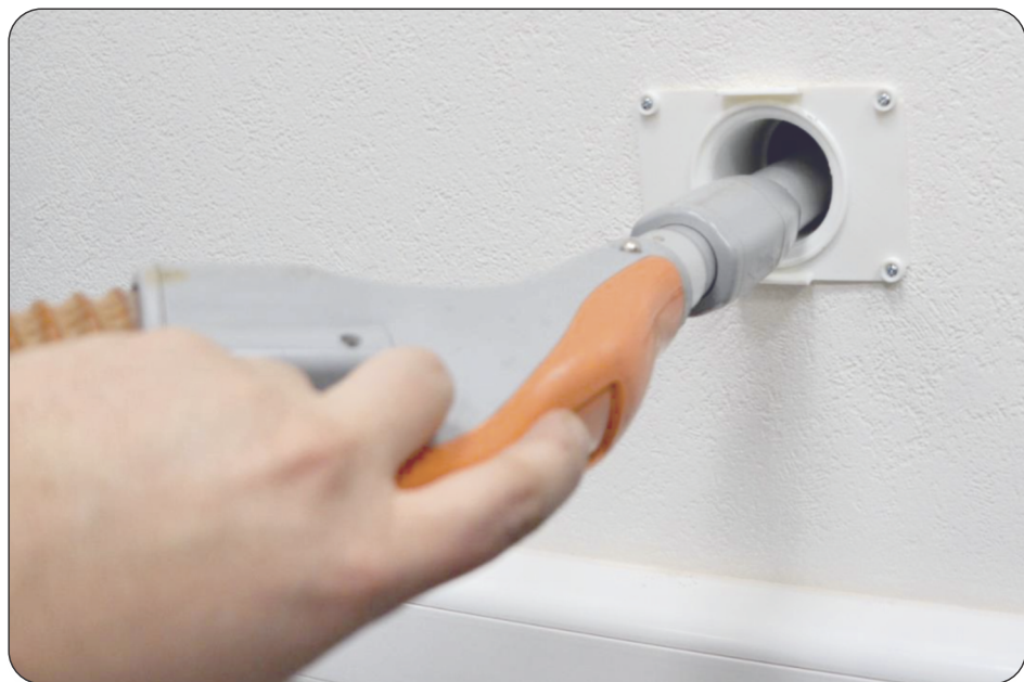
Рис. 8. Очистка воздухопроводящего канала бытовым пылесосом
